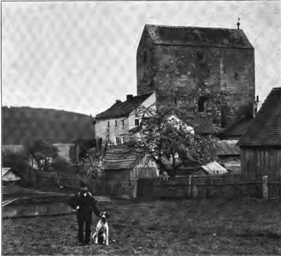
Fig. 42. Hof am Regen. Südwestansicht des Kapellenbaues der Burg.
